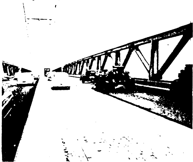
Figura XI-2. Repavimentación de las calzadas estropeadas de un puente de hormigón de cemento Portland por medio de hormigón asfáltico.
