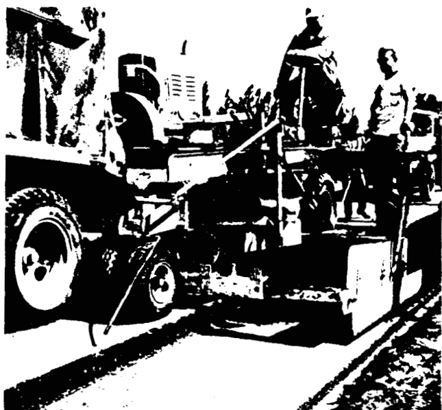
Figura IX-1. Base de hormigón asfáltico extendida con un anejo especial de la pavimentadora para ensanchar una carretera.
