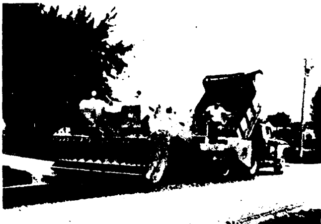
Figura VIII-22. Extensión de árido para el tratamiento superficial con una esparcidora autopropulsada.
