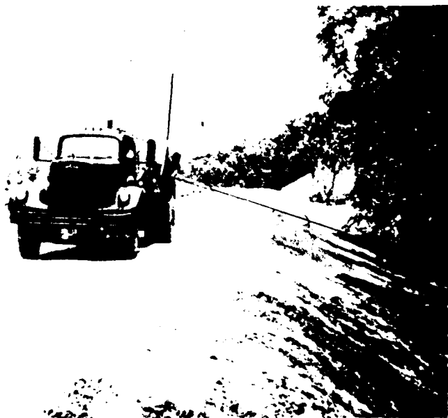
Figura XV-8. Aplicación de asfalto a laderas recubiertas de paja mediante una barra extendidora lateral unida al camión distribuidor.
