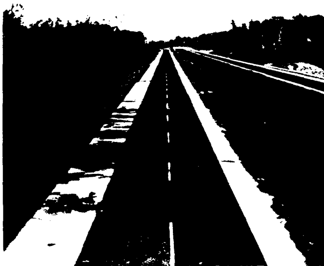
Figura X-1. Pavimentación de arcenes en la totalidad de la anchura.
