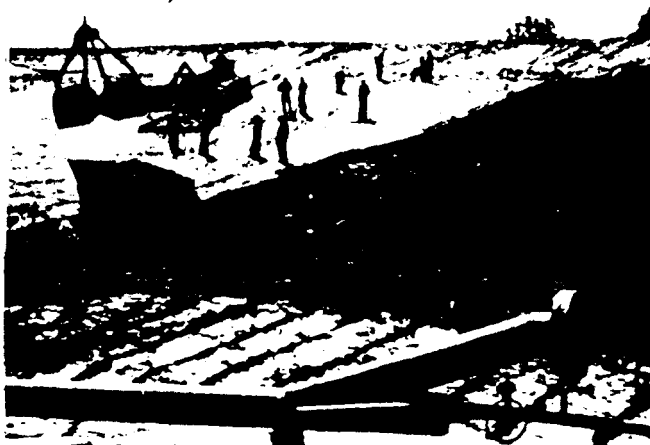
Figura XIV-8. Revestimiento de la orilla superior del río Mississippi.
