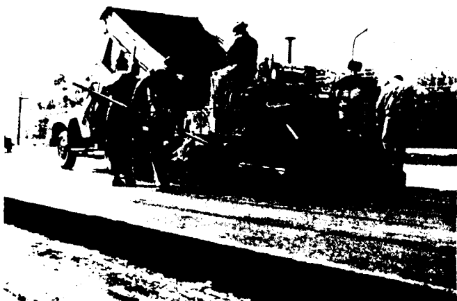
Figura WI-5. Extensión de arena-asfalto con una pavimentadora.
