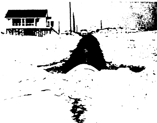
Figura XIV-12. Dique de asfalto para la arena.
